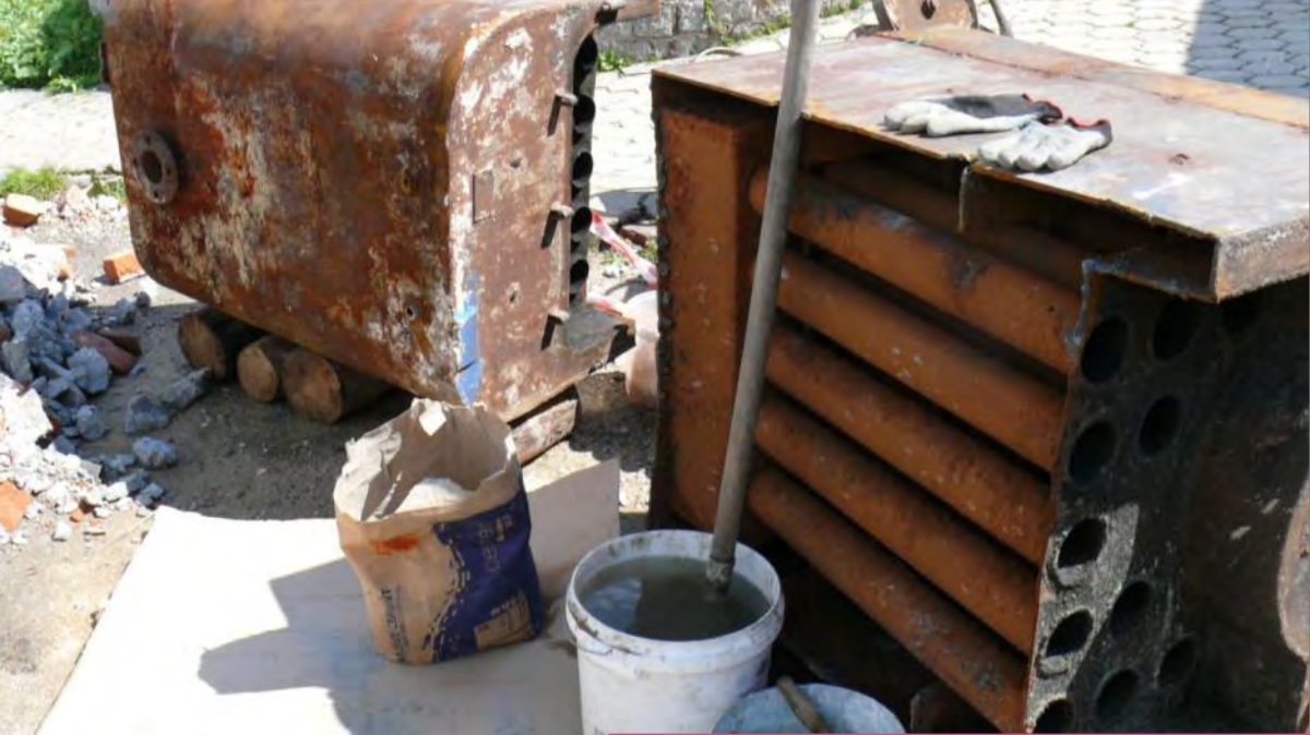
Zdemontowane stare poniemieckie kotły
