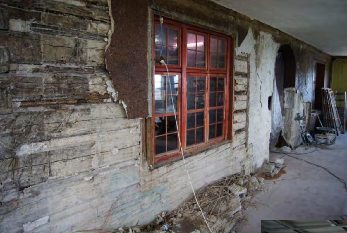
Ściana wewnętrzna sali głównej przed modernizacją
