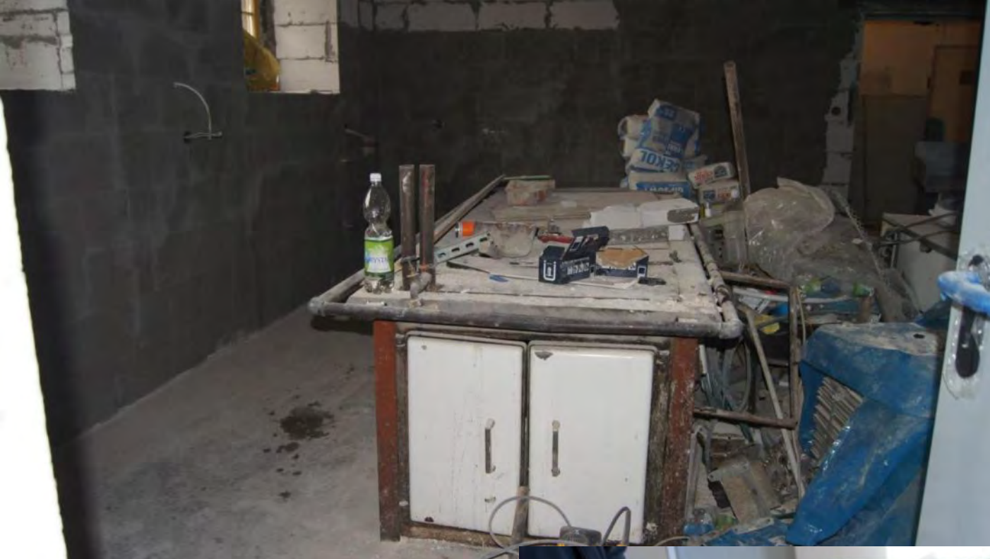
Kuchnia właściwa przed modernizacją
