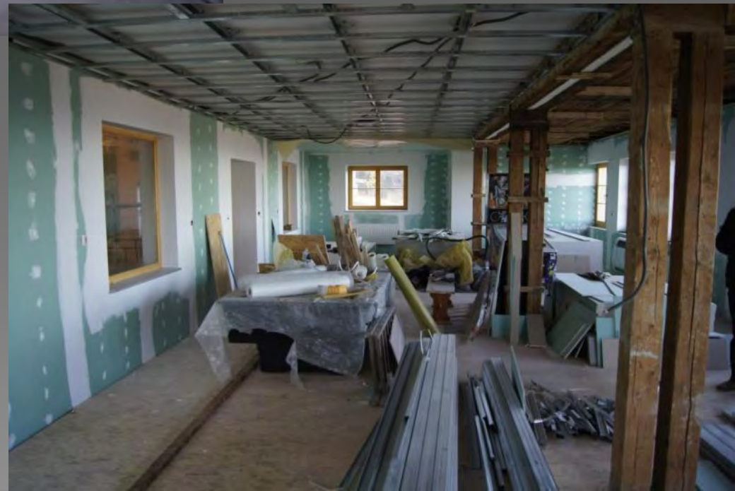
Wnętrze sali głównej w trakcie modernizacji
