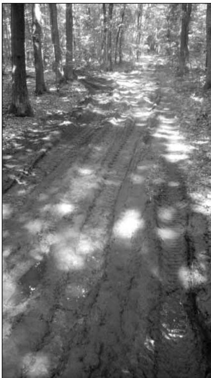
Rys. 2. Stan dróg leśnych po przejeździe ciężkich samochodów podczas wózki drewna (Lasy Chojnowskie) Źródło: archiwum autora (2017)
