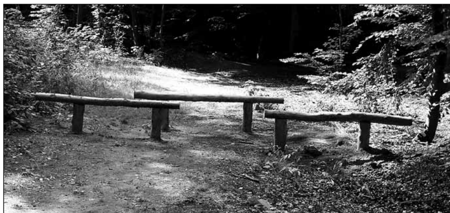
Fot. 5. „Zwalniacz” szybkości przejazdu na skrzyżowaniu szlaku rowerowego z drogą publiczną w Nadleśnictwie Kolbudy Źródło: Z. Popławski
